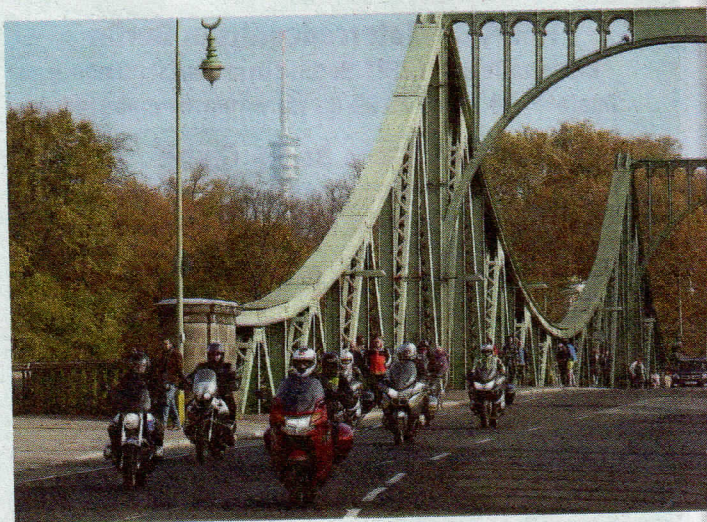
Der Weg führt unter anderem über die Glienicker Brücke
